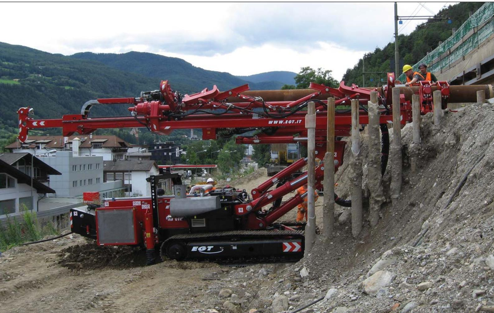
Le Perforatrici i Class8, polifunzionali certificate CE versatili e con elevate doti di manovrabilità, utilizzano le più avanzate tecnologie meccaniche al servizio della perforazione nell'ambito dell'ingegneria civile, in modo da fronteggiare al meglio le più gravose necessità di cantiere.
